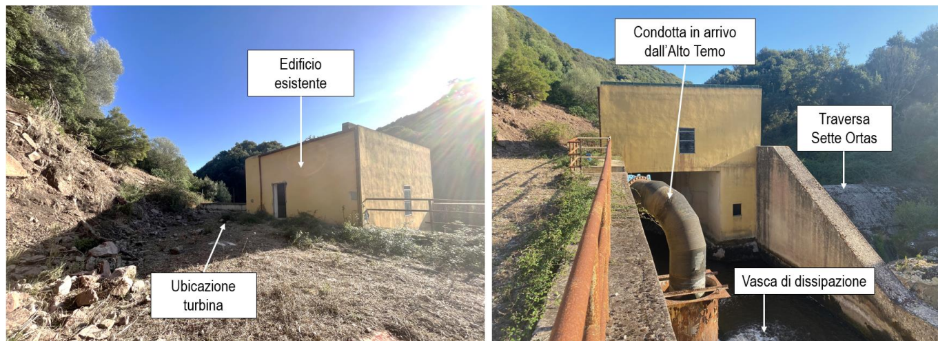
Figura 3-2 – Edificio esistente con principali manufatti esistenti e ubicazione impianto
